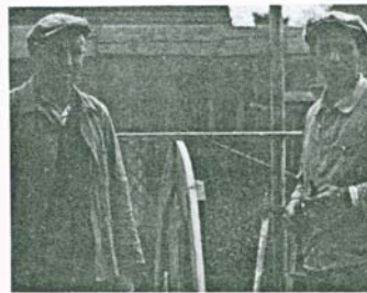
Vater Wilhelm Faas (links) als junger Maurergeselle beim Verschalen eines Gewölbekellers. Die Aufnahme von 1935 zeigt neben ihm seinen Kollegen Otto Reiser.
